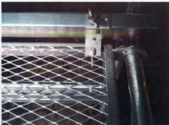
①板のエキスパンド面に爪を引っ掛ける
